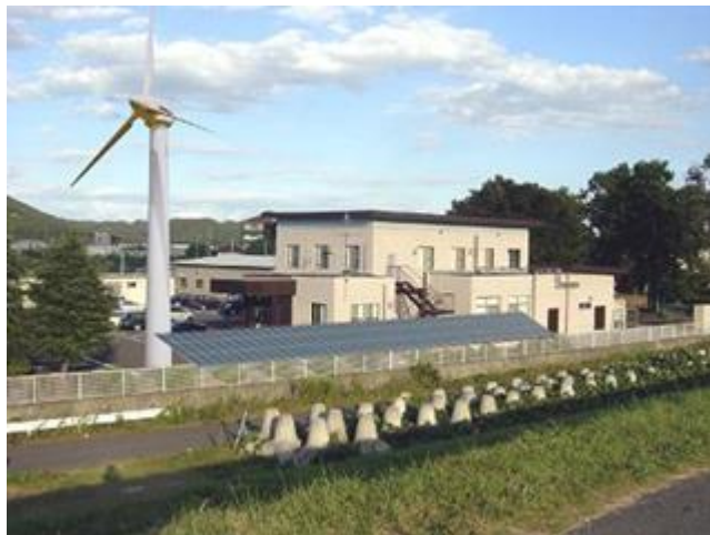
足利大学（風力40kw、太陽光20kW） 再生可能エネルギーにより製造した水素の長期、 安定貯蔵に利用
