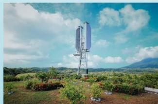
プロペラによる揚力ではなく、円筒の回転で発生するマグナス力を利用して、制御できる風速域を広くする
