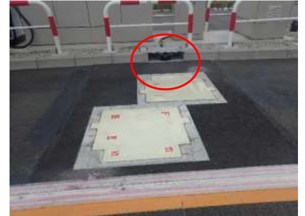
地上コイル脇に地面すれすれに設置されたレーザーセンサー
