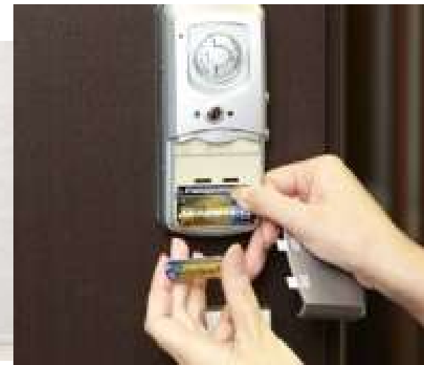
電子ロックの電池交換作業
