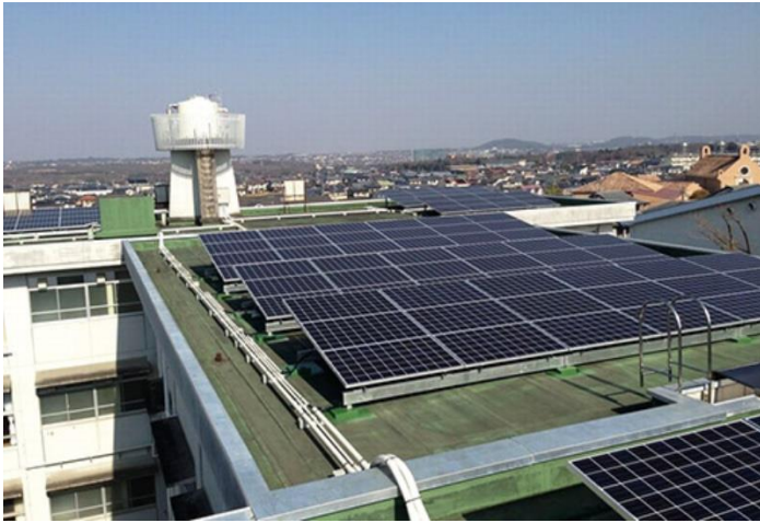
公共建築物などの屋根
