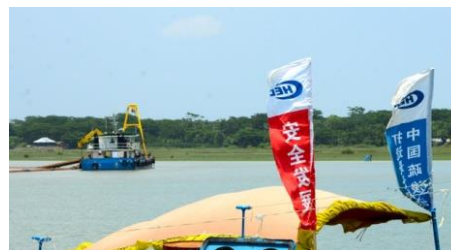
パイラ港で浚渫作業をする中国船
