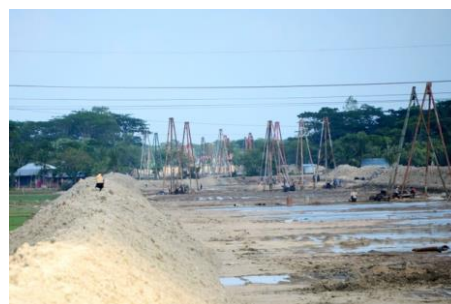
パイラ港に通じる道路の建設現場 ＝全て武石英史郎撮影
