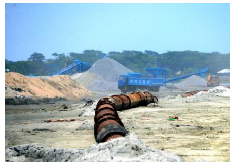
母港の候補地パイラ港建設現場
